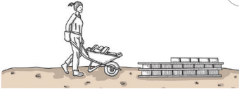
Etapas N°3: Recolección de los bloques de tierra compactada y llevados a la construcción de los muros de la casa.
